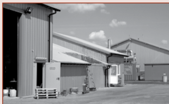
Fot. 2 Ogólny widok na infrastrukturę biogazowni, fot. P. Gołasa.
